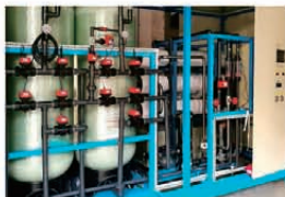
○ 超纯水处理系统 Ultrapure water treatment system
